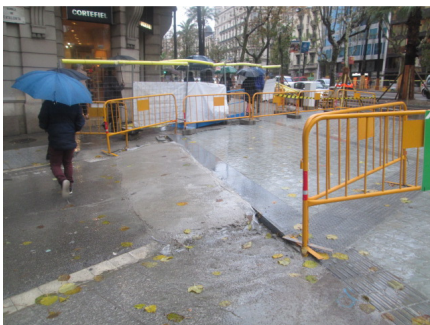
Exemple de rampa de formigó d'accés de vehicles en fase d'obres
