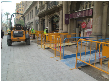
Exemple de feines adossades a façanes successives i diferents sistemes d'accessibilitat
