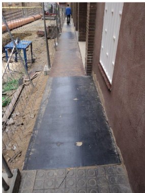
Exemple de col·locació de xapa de protecció de rasa/pou
