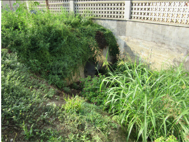
Entrada al col·lector de pluvials ubicada aigües amunt de la rotonda on intersequen el carrer de les Orquídies i el carrer de Josep Pallach
