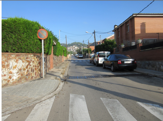
Vista del carrer de la Ginesta des de l'encreuament amb el carrer Prat de la Riba. Es pot apreciar la reixa interceptora ubicada al final del carrer de la Ginesta.
