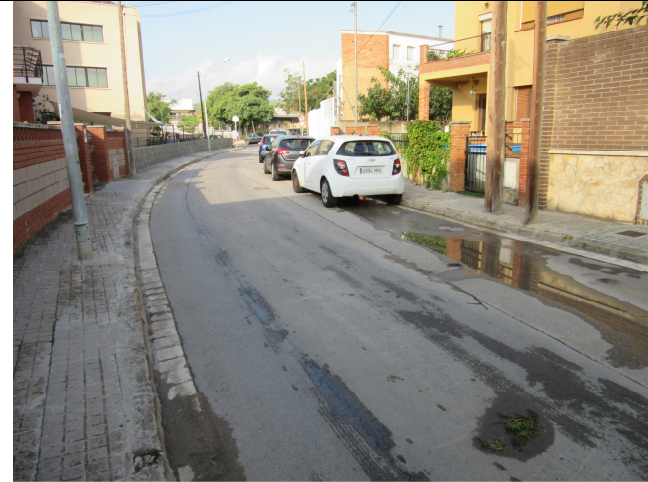
Vista del Passeig del Tamaríu. Tram entre l'avinguda Central d'Albarrosa i el carrer de les Margarides. Carrer afectat per la Fase 1.
