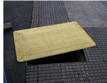
Planxa de fibra de vidre reforçada amb rodó metàl·lica
