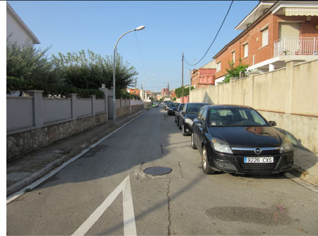
Vista de secció típica d'urbanització del barri d'Albarrosa. La foto es correspon amb el carrer de la Ginesta. La tapa de pou de registre que es pot apreciar a la imatge es correspon amb un pou de la xarxa de residuals.
