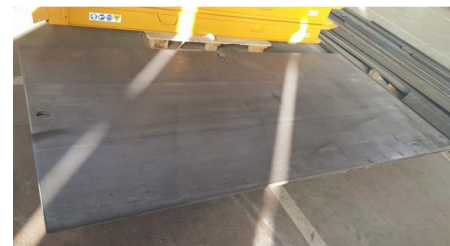
Placa de ferro per a cobertura de rases apta per al pas de vianants i vehicles
