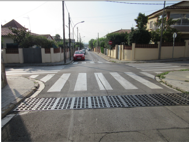
Vista de la reixa interceptora del carrer de la Ginesta ubicada a la intersecció amb el carrer de les Orquídies.
