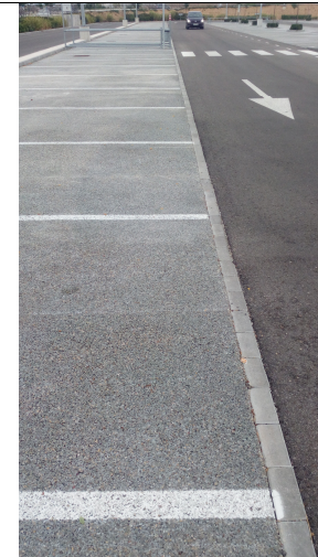
Paviment permeable en una zona d'aparcament d'un centre comercial
