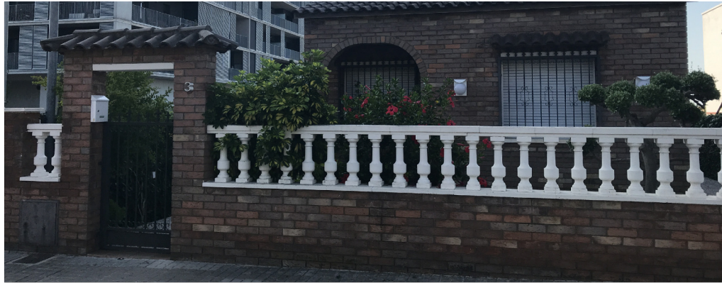
FOTO ESTAT ACTUAL CARRER DELS LILÀS 6
