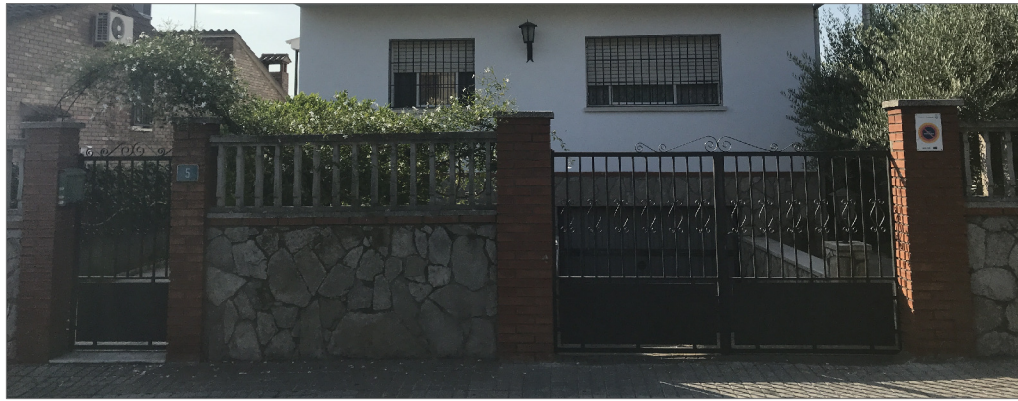
FOTO ESTAT ACTUAL CARRER DELS LILÀS 6
