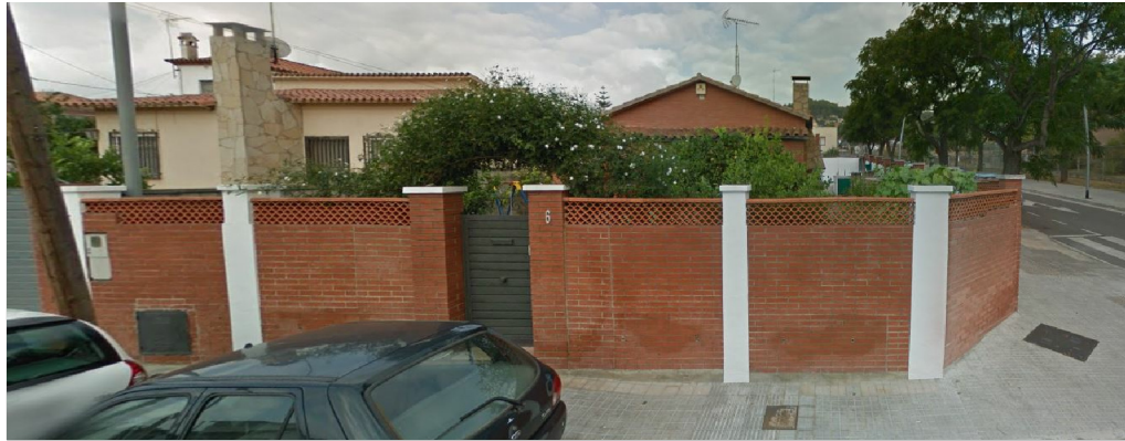
FOTO ESTAT ACTUAL CARRER DELS LILÀS 6
