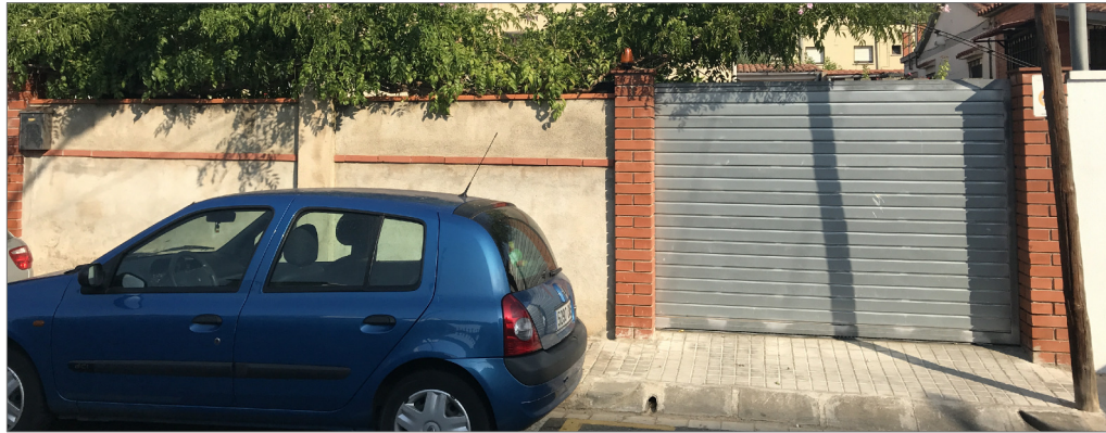
FOTO ESTAT ACTUAL CARRER DELS LILÀS 6
