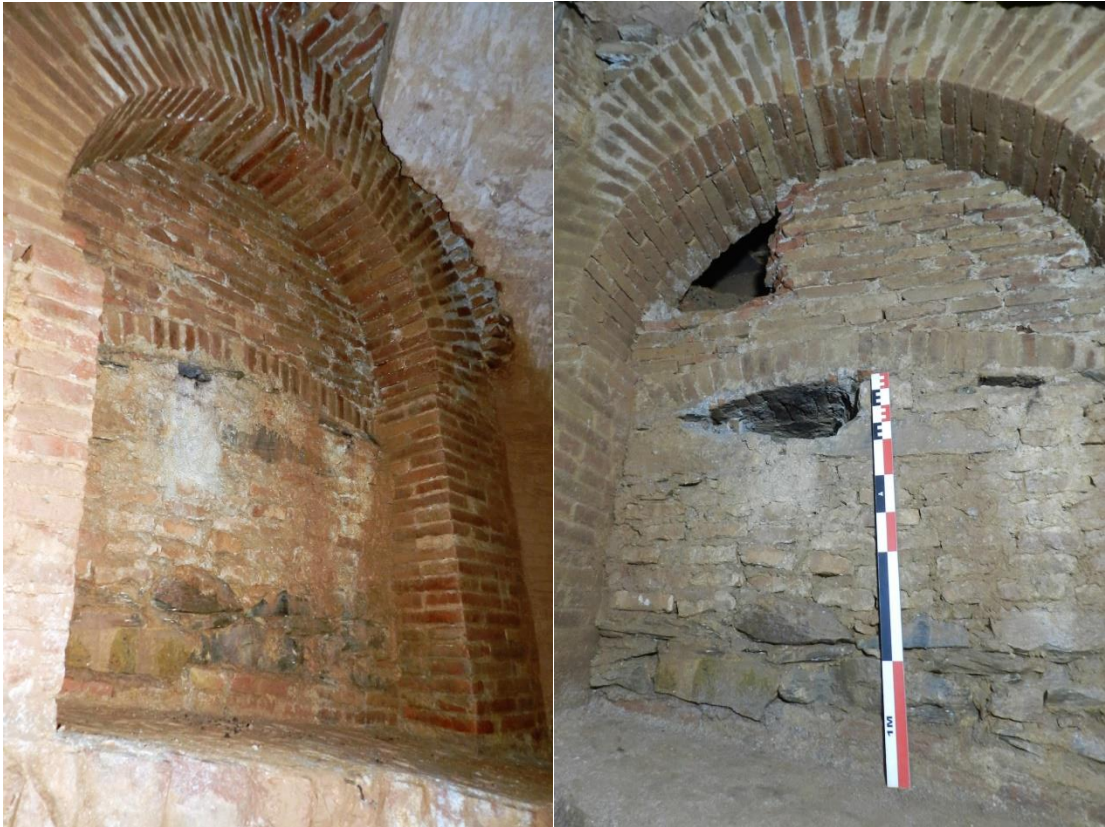
Portal paretat situat en el punt d'inflexió entre la galeria procedent del carcabà inferior i la unió amb la connexió amb la mina. Prospecció feta al portal. Dalt trobem la canalització de la sala de moles antiga. L'arcada inferior es constata que correspon a una volta amb continuïtat
