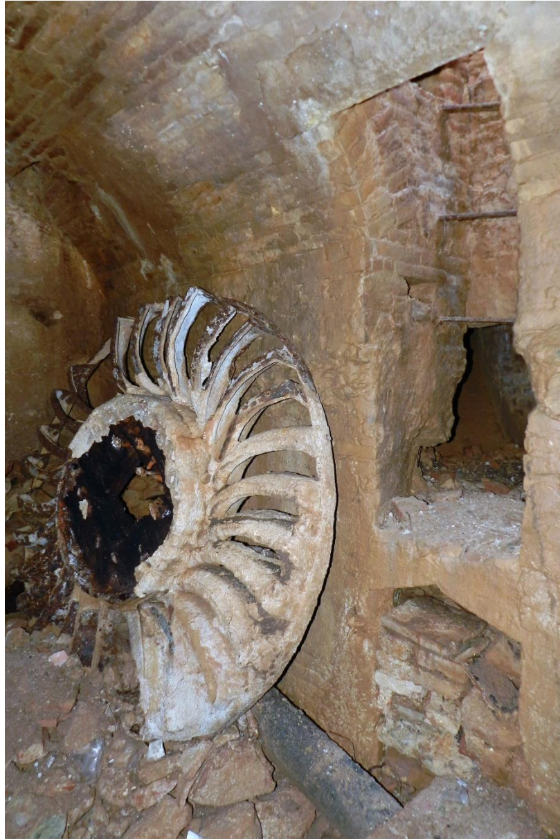
Carcabà inferior, rodet i accés lateral des del registre superior de la sala de la mola. En la base de l'accés una canalització d'obra procedent de la bassa inferior per buidar la bassa sense fer rodar el rodet.
