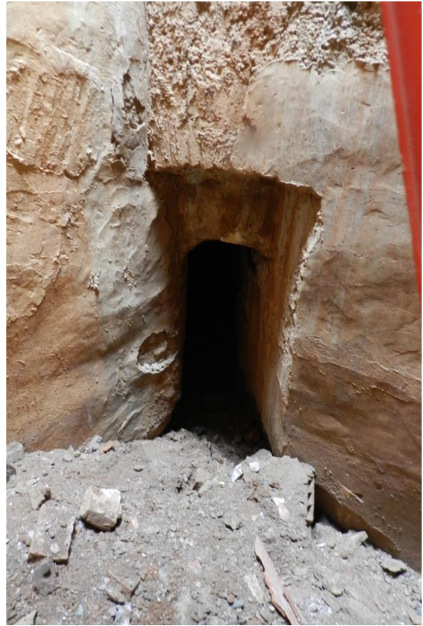
A l'esquerra porta d'accés el carcabà antic des de la sala de la roda. A la dreta el desguàs en mina de l'espai de la roda hidràulica
