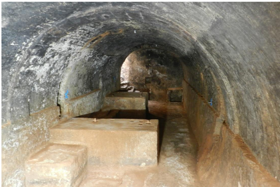
Vista del carcabà antic amb els bancades on s'emplaçaven els rodets
