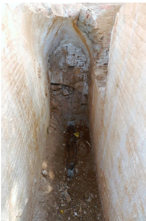
Pas de comunicació de l'aigua entre la bassa superior i la sala lateral sud del carcabà. Al fons es troba la canonada del 1929
