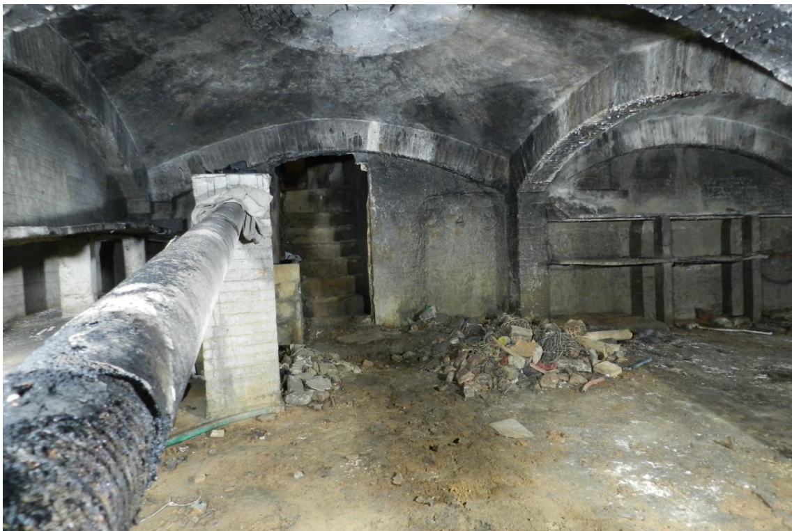
Bassa inferior abans de ser netejada. En primer terme el tub de canalització d'aigües de 1929
