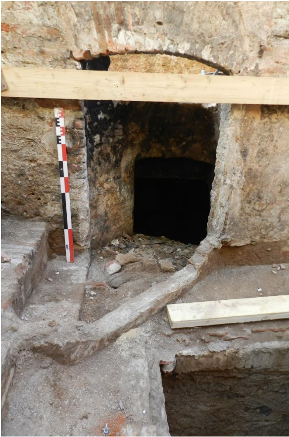
A l'esquerra porta d'accés el carcabà antic des de la sala de la roda. A la dreta el desguàs en mina de l'espai de la roda hidràulica
