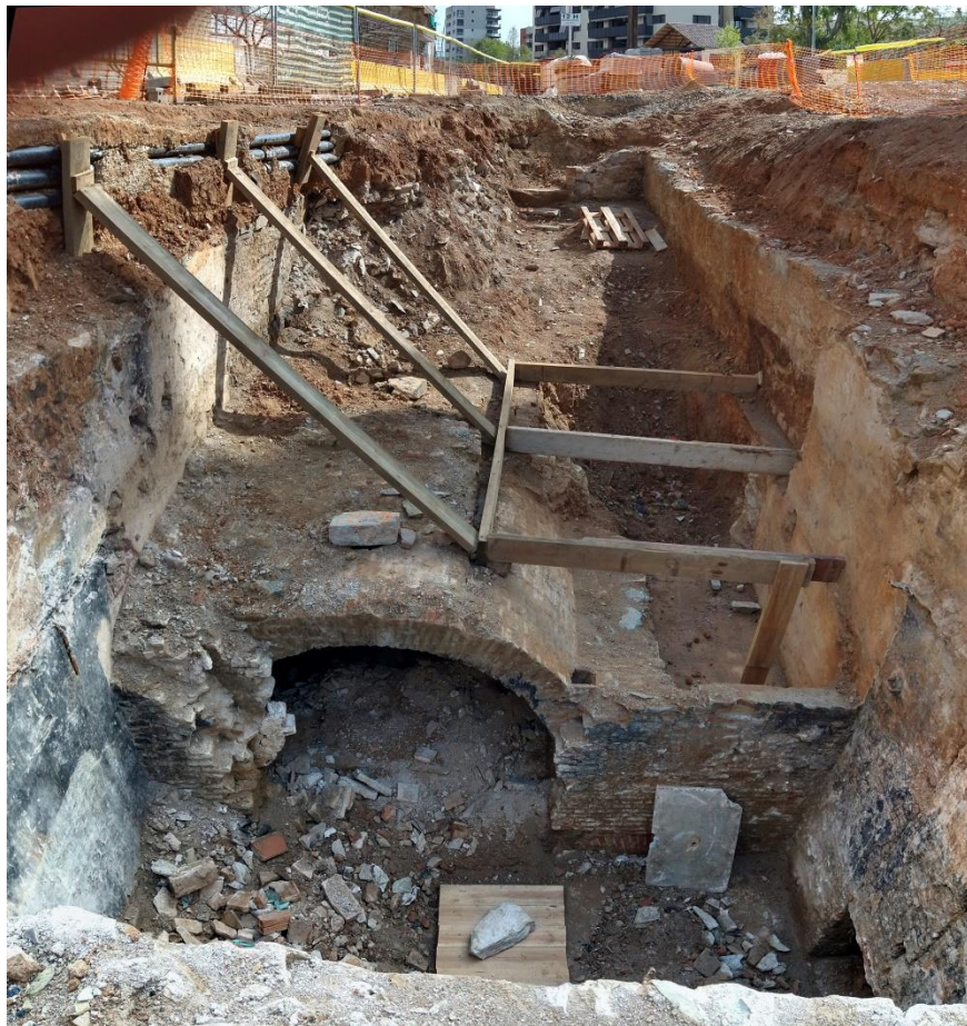
Vista del sector de llevant. En primer terme i més inferior la sala de la mola de la bassa inferior, abans de la nostra intervenció. S'observa el nivell de circulació a la cota de la volta de canó adossada. (Manuel Luengo estiu 2022)
