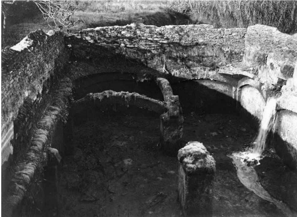
En la imatge es pot observar part les arcades de les voltes de coberta encara conservades i l'entrada de l'aigua exterior canalitzada Fotografia datada entre els anys 1926-1928. (J Mas Guardia. Arxiu C.E.C.)
