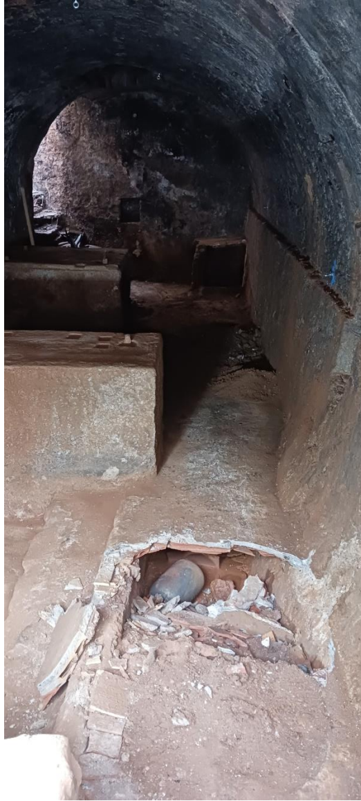
Detall del canal tapiat sota el carcabà antic
