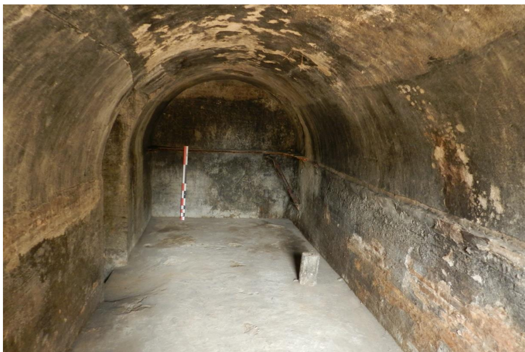
Carcabà de la bassa superior. El cup que aportava l'aigua està paretat.
