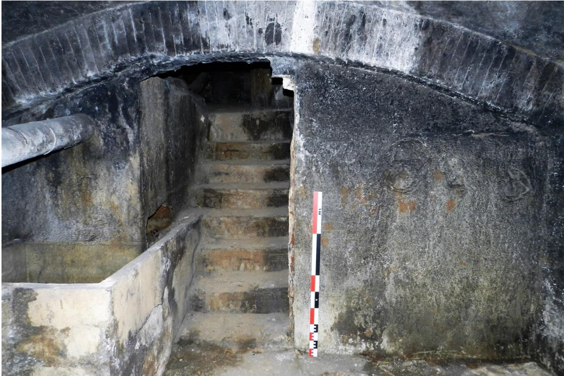
Escala actual d'accés entre el carcabà superior i la bassa inferior, vist des de l'interior d'aquesta
