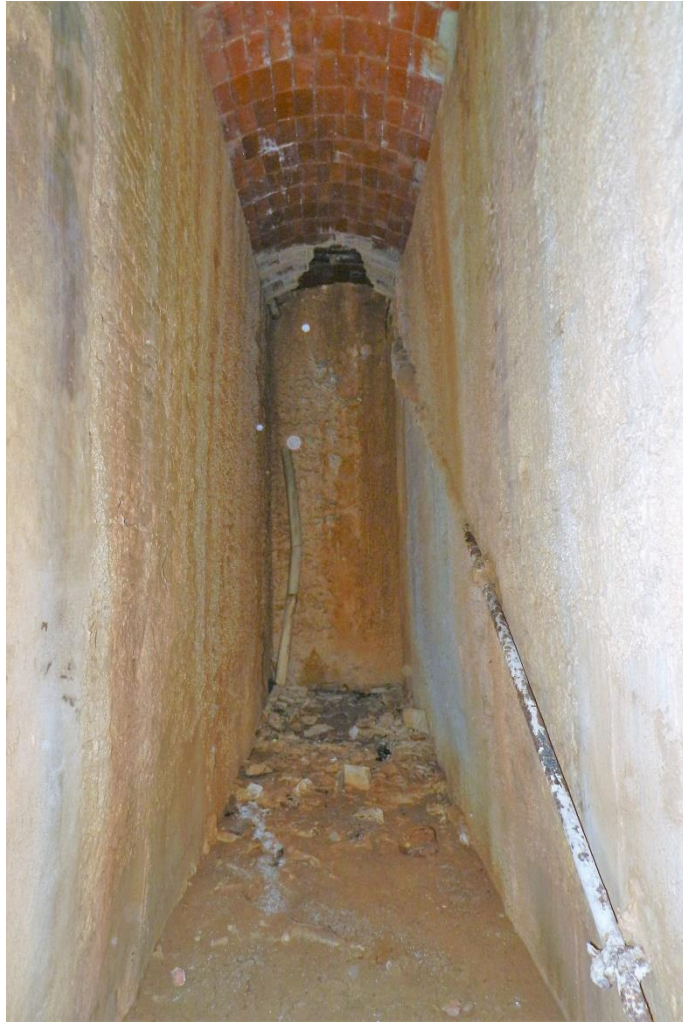
Espai de la roda hidràulica. A la dreta el tub de ferro
