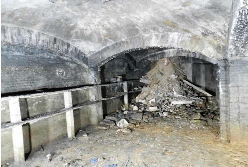
Bassa o dipòsit inferior abans de la neteja de les deixalles i runes procedents d'un pou superior.
