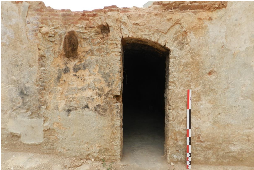
Accés actual al carcabà de la bassa superior.
