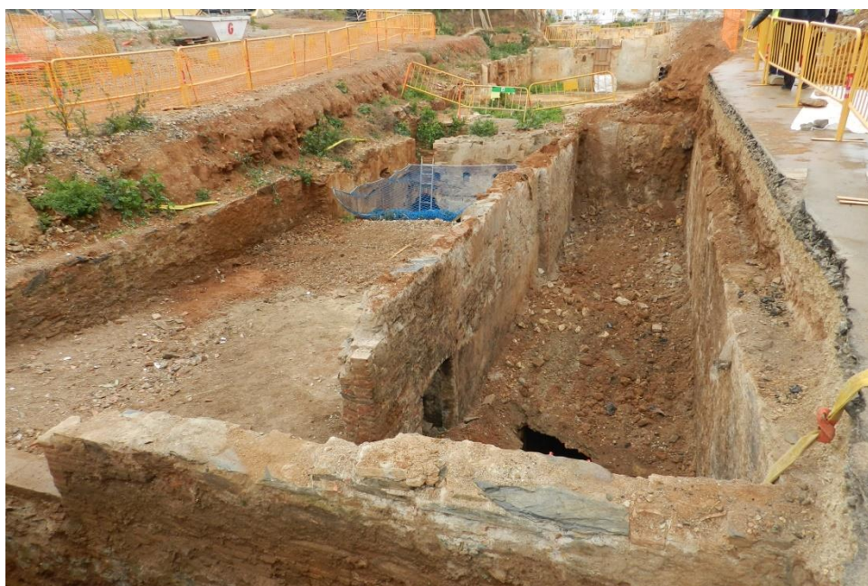
Espai de la roda hidràulica, coberta i amb terres
