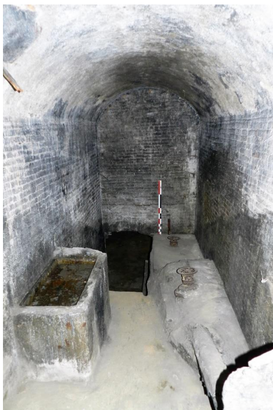
Sala lateral sud al carcabà de la bassa superior i comunicació actual amb escala vers la bassa inferior. Es pot veure la canonada de 1929 que travessa l'espai longitudinalment
