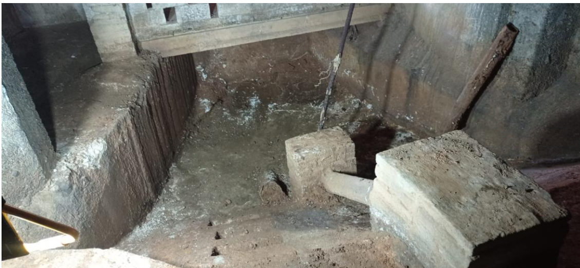
Espai de desguàs a l'extrem est del dipòsit per on discorria l'aigua amb força de la bassa inferior al carcabà inferior. Actualment el cup està ocupat per la instal·lació de la canonada de 1929
