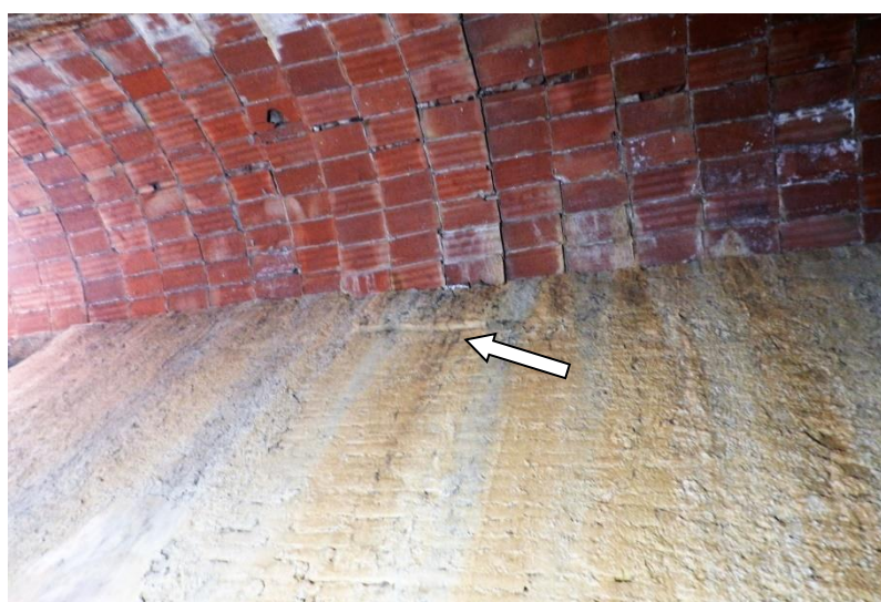
Carreu de suport de l'eix de la roda hidràulica
