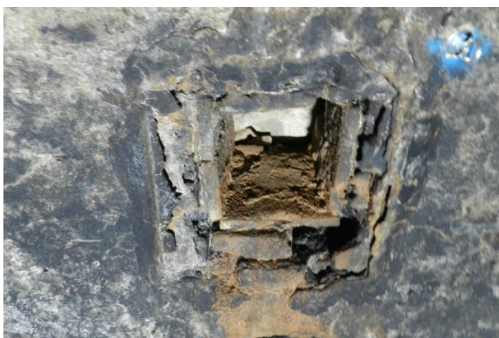
Detall de del forat per on passava l'arbre o eix de la mola
