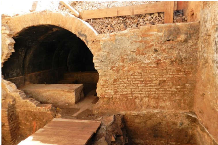
A la dreta, mur lateral sud de la sala de la mola on s'observa un registre paredat amb obra. A sobre, sala de moles antiga situada al costat est i que havia estat tancada pel mur d'obra parcialment conservat.
