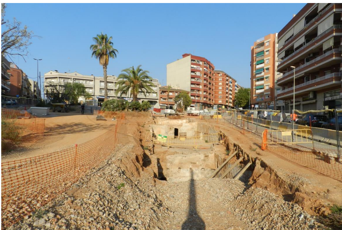
Fotos de l'estat inicial de la intervenció (20/08/2023)
