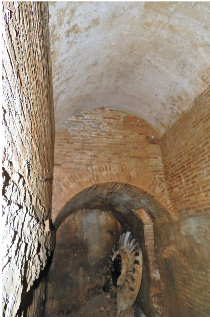
Carcabà inferior amb el rodet desplaçat. Als laterals es pot Observar l'arrencada d'una volta anterior, modificada i sobrealçada al nivell actual
