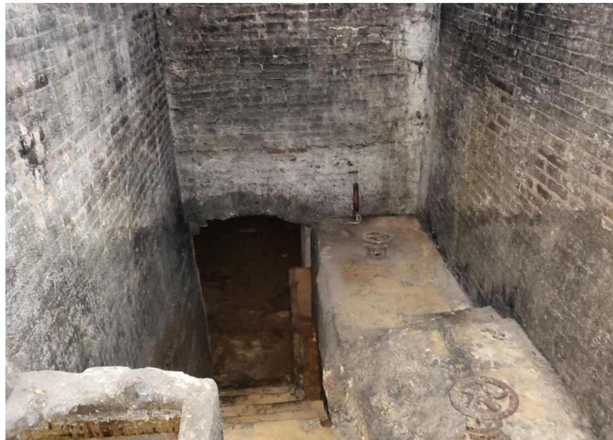
Figura 10. Galeria sota la qual hi ha l'escala que accedeix directament a la zona de la bassa inferior a data 29/11/2022. Tot i que l'aspecte aparent pugui ser similar al de la volta superior del carcabà inferior no s'observen col·lapses parcial ni patologies significatives com per presuposar un estat ruïnós. Per aquest motiu aquest àmbit serà objecte de la prova de càrrega, esperant un millor comportament estructural durant la prova de càrrega i durant el futur comparat amb la zona del carcabà inferior.
