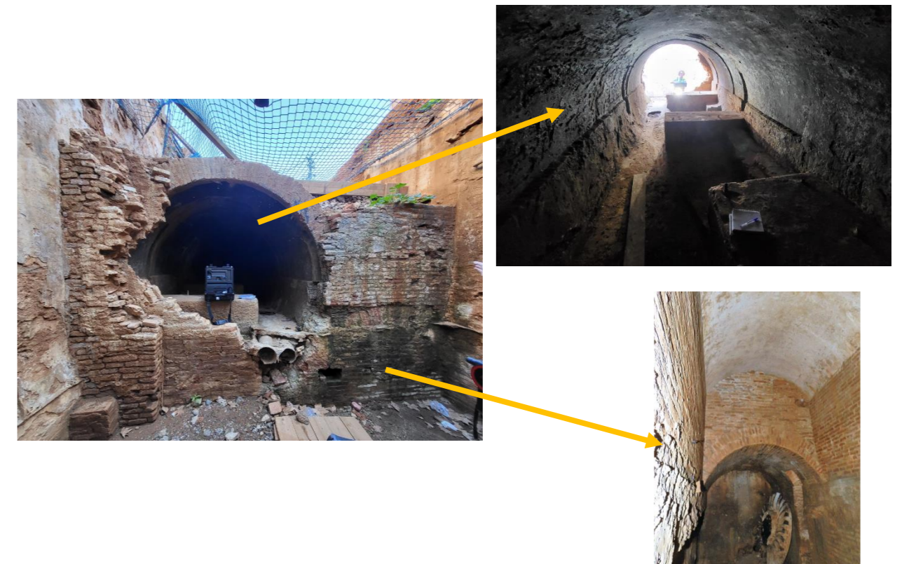
Figura 7. Voltes i murs de càrrega d'obra de fàbrica que conformen la zona del carcabà inferior.
