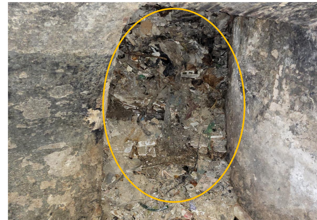
Figura 5. Presència d'escombraries/ runa en trasdós de volta superior del carcabà inferior i segurament entorn a l'estructura soterrada el qual pot incidir molt desfavorablement en una alta compressibilitat del rebliment induint esforços horitzontals no homogenis a data 29/11/2022.
