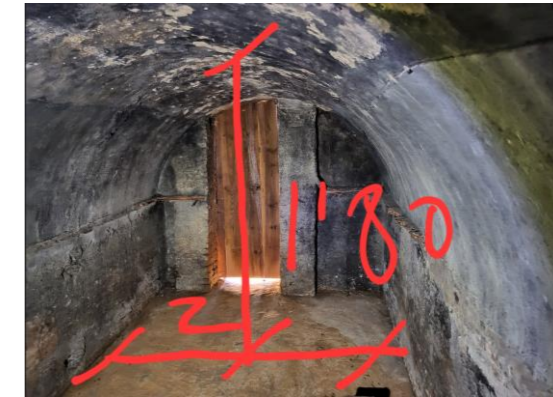
Figura 11. Interior d'una de les voltes en la zona del carcabà superior.
