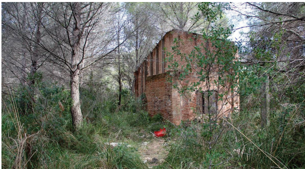
Imatge 14. Restes d'edificacions a l'interior de l'àmbit
