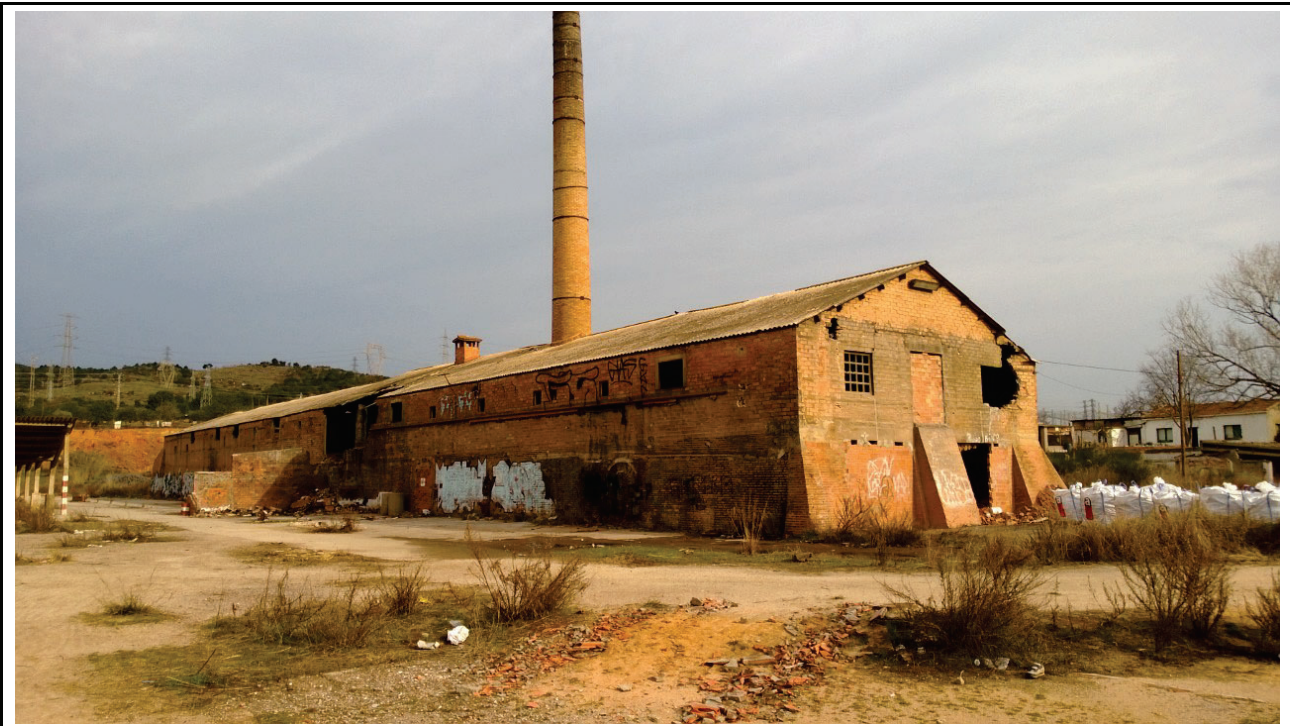
Vista general de l'edifici original que allotjava el forn i la xemeneia de la Bòbila de Sales.
