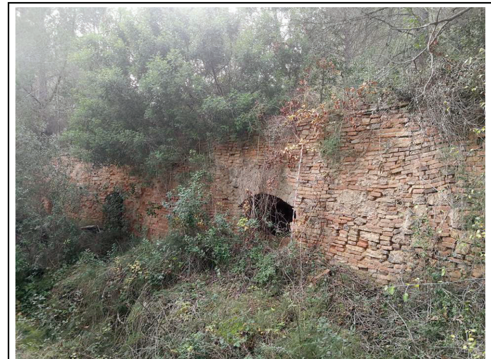
Foto 8. Vista general de la façana est del forn.
