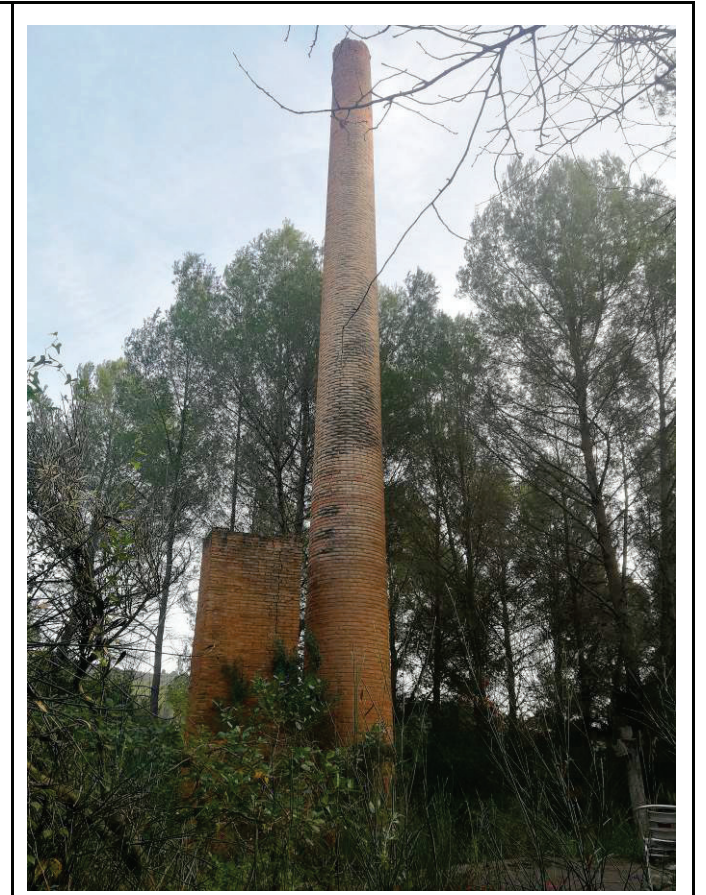
Foto 4. Vista general de la xemeneia.
