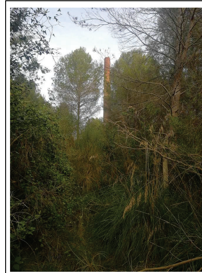
Foto 3. Vista general de la xemeneia i el seu entorn.
