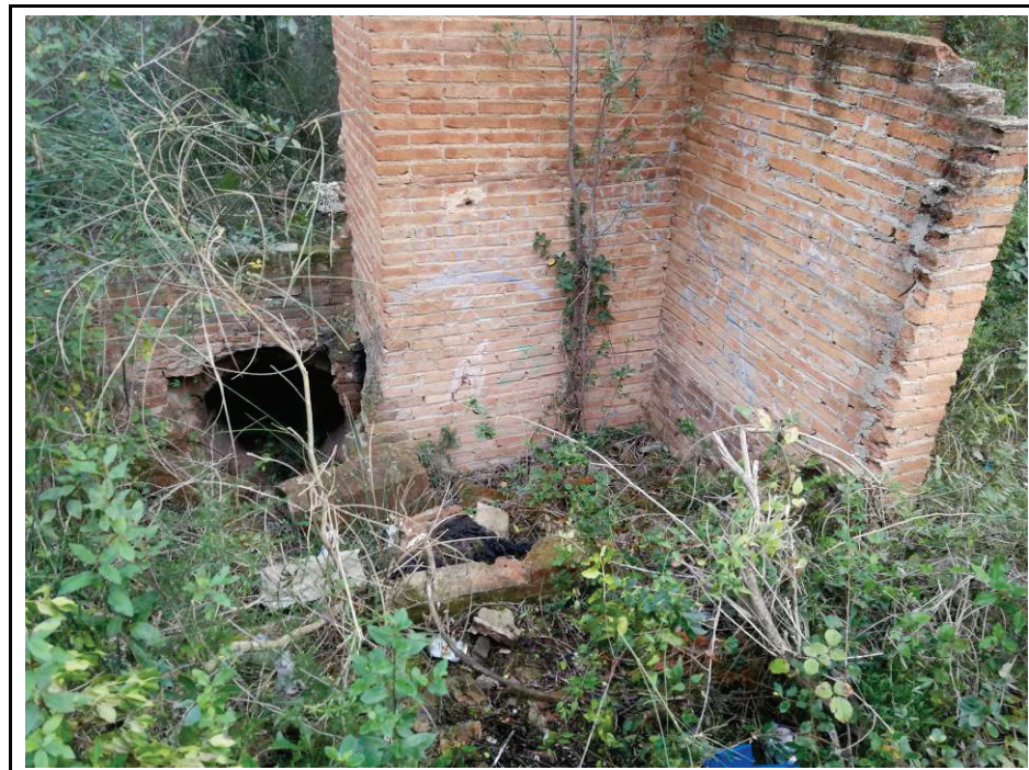
Foto 14. Part de l'estructura del fumeral que connecta el forn i la xemeneia..
