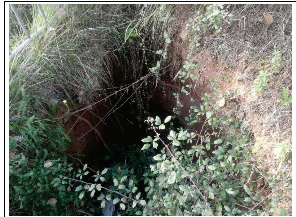
Foto 19. Restes d'una conducció subterrània al costat de la carretera.
