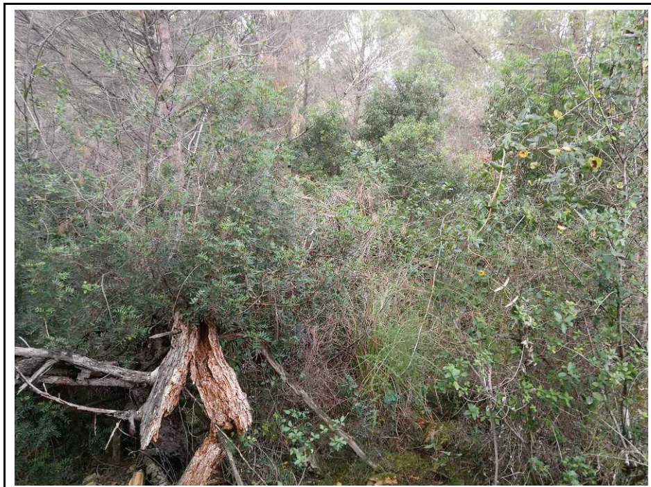
Foto 10 Estat de la part superior del forn totalment envaïda per la vegetació.
