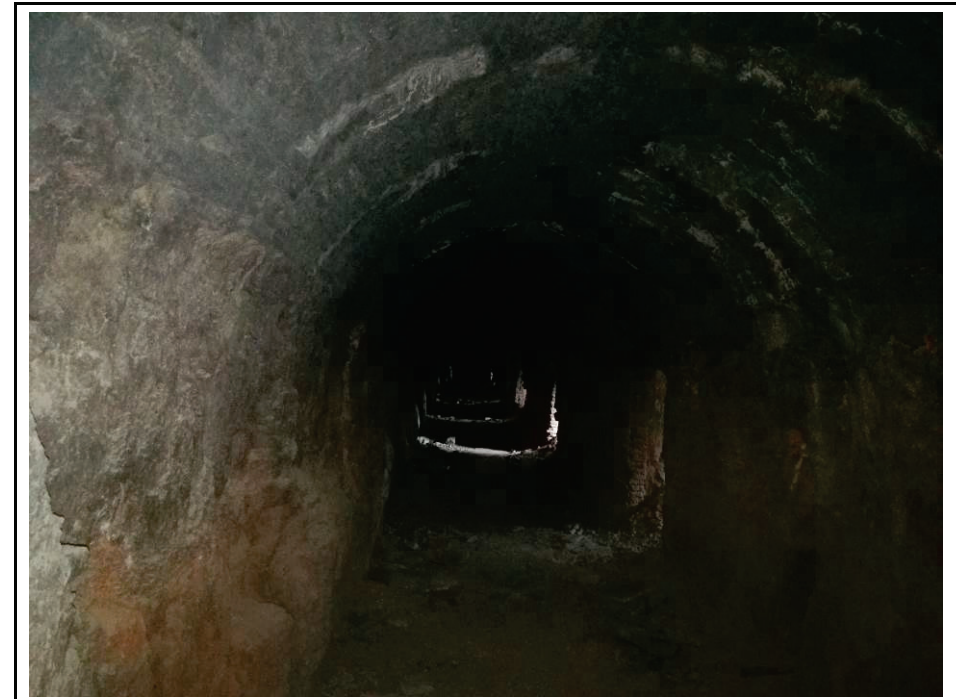
Foto 11. Interior de la galeria est del forn.
