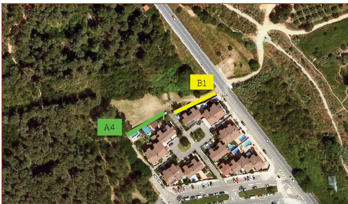
Imatge 13: Detall de la zonificació de les façanes previsiblement més afectades.
