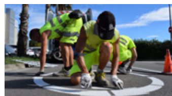
Repintado de señales horizontales
