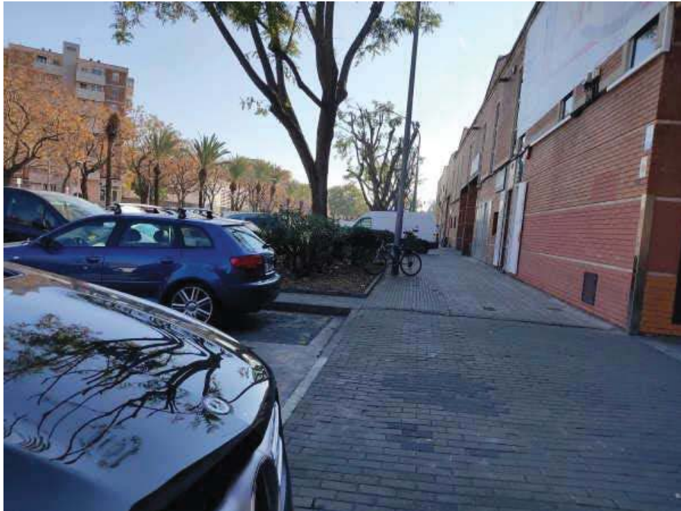
Figura 13. Fotografía a pie de acera tomada desde el extremo noreste
