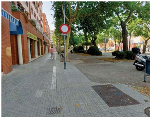
Vorera oest de la carretera de la Vila
