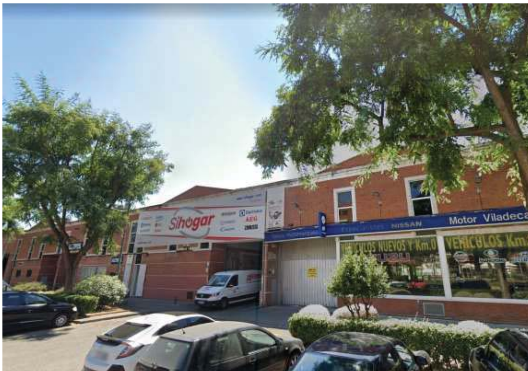
Figura 5. Fotografía a pie de calle tomada desde el extremo noreste
