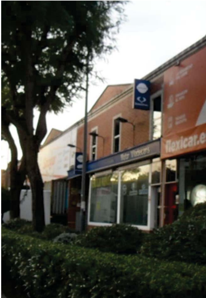
Vistas del exterior de la nave existente
