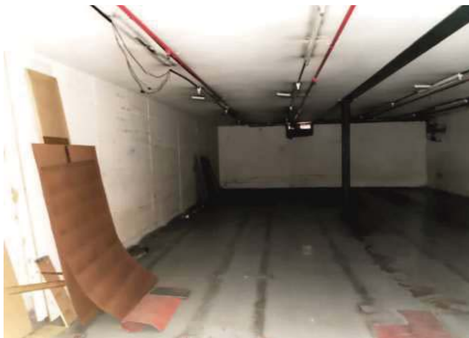
Figura 10. Vista de la nave existente (planta sótano)
