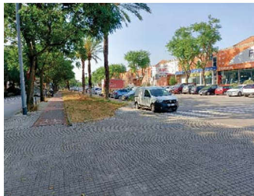
La vorera a la mitjana entre els dos espais de calçada de la carretera de la Vila no té amplada suficient per als vianants, ja que l'espai és ocupat per un carril bicicleta
