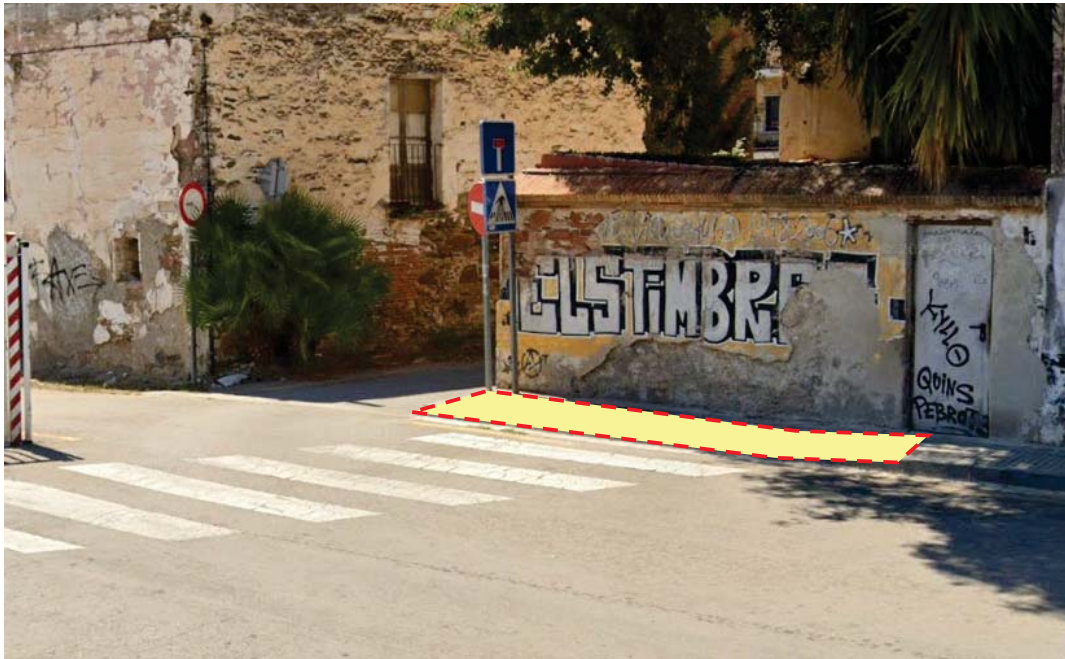
Figura 6.2. Espai aproximat de la vorera del pas de vianants a rebaixar per completar-ne l'accessibilitat
