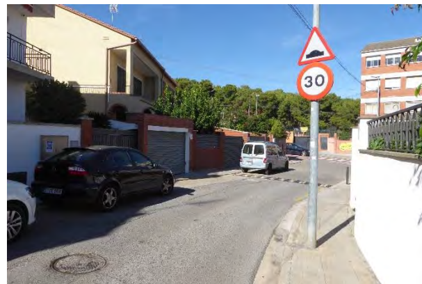
Vorera estreta, amb amplada útil inferior a 0,90 metres al carrer Acàcia
