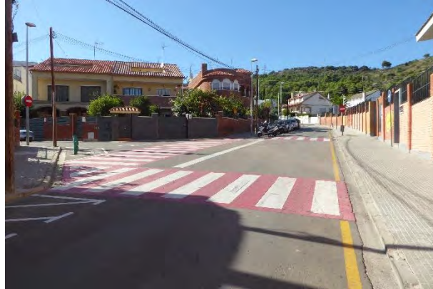
Passos de vianants ben remarcats en vermell davant de l'escola, tot i que manca fer-los accessibles
