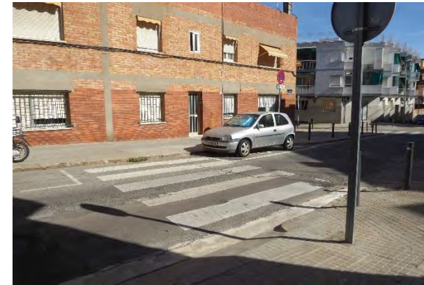
Pas de vianants no adaptat a Circumval·lació – Petúnia
