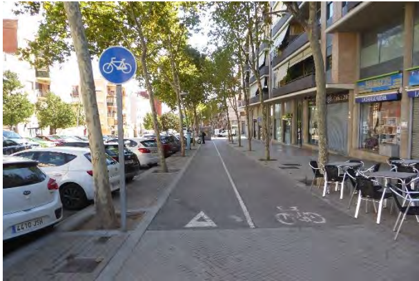
Carril bici a l'avinguda de Ballester
