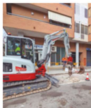
Obres a la carretera de Barcelona
