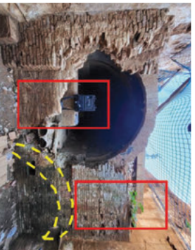
Figura 7. Vista de la zona de treball de la plataforma de costat plaça per a l'execució de pilots. S'indiquen les zones de treball de les plataformes per a poder anar a l'obra de manera selectiva i sense d'excavar d'edifici.
