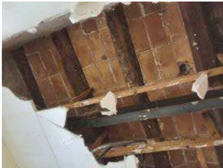
Sostre amb 4 bigues originals de fusta, revoltons no originals
