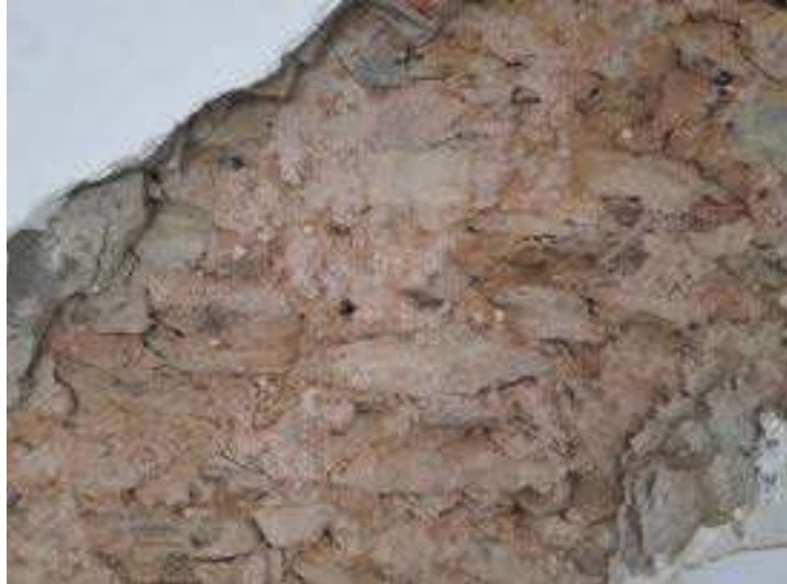
Detall de la composició de la paret interior de l'antiga masia
