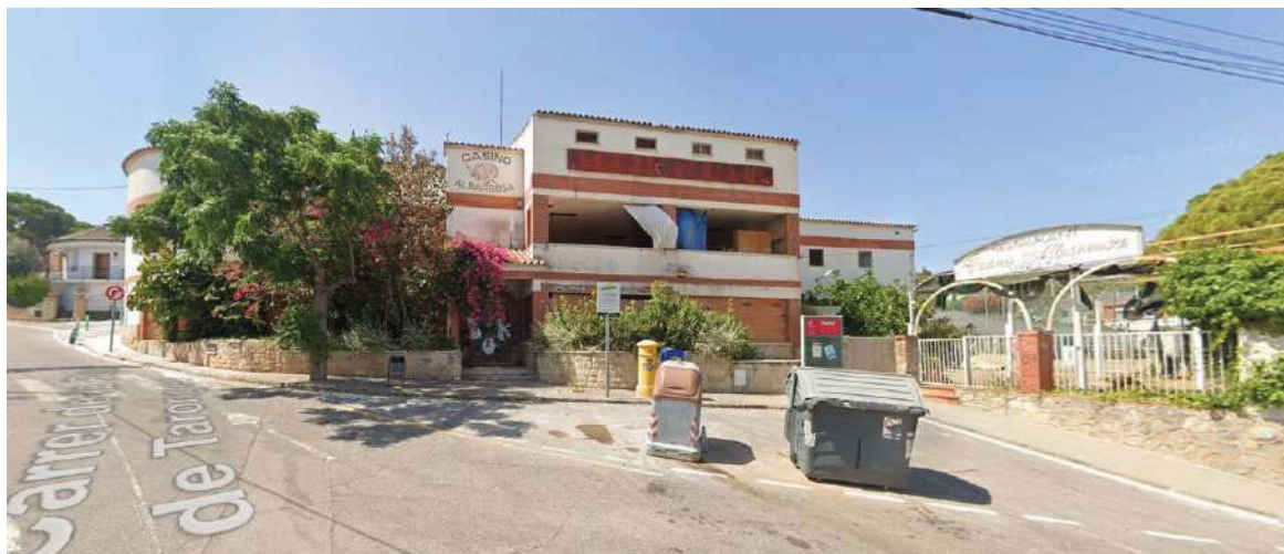
Figura 2. Edifici abans d'enderrocar
