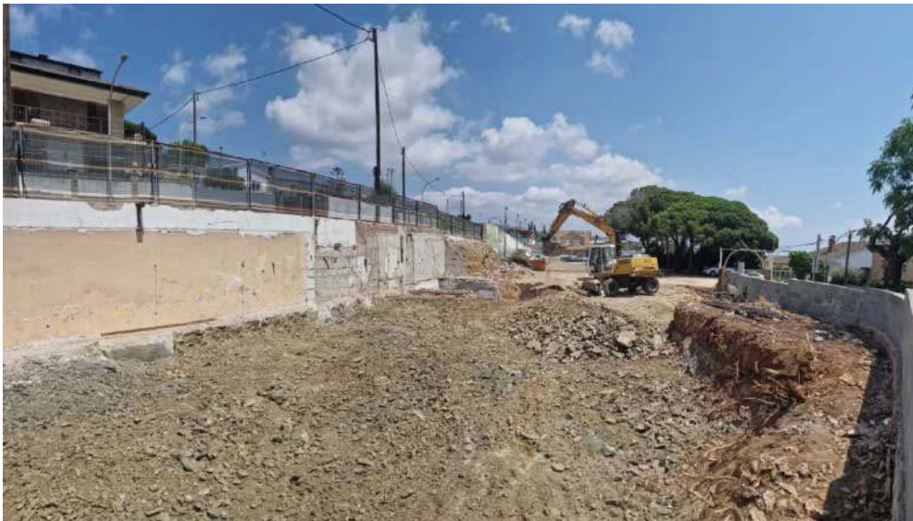
Vista des del Carrer la Flor del Taronger, s'observa l'estat actual de la parcel·la, després de l'enderroc de l'edifici.
