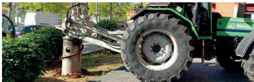
Actuaciones de mantenimiento del alumbrado, seguridad vial y retirada de raíces
