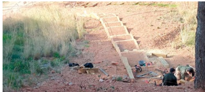
L'Ajuntament està construint unes escales amb una barana en un tram
