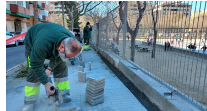
La Brigada Municipal repara las baldosas levantadas en una acera
