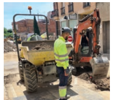
Obras en la calle de la Antiga Riera
