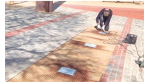
Actuaciones en embornales y espacios peatonales
