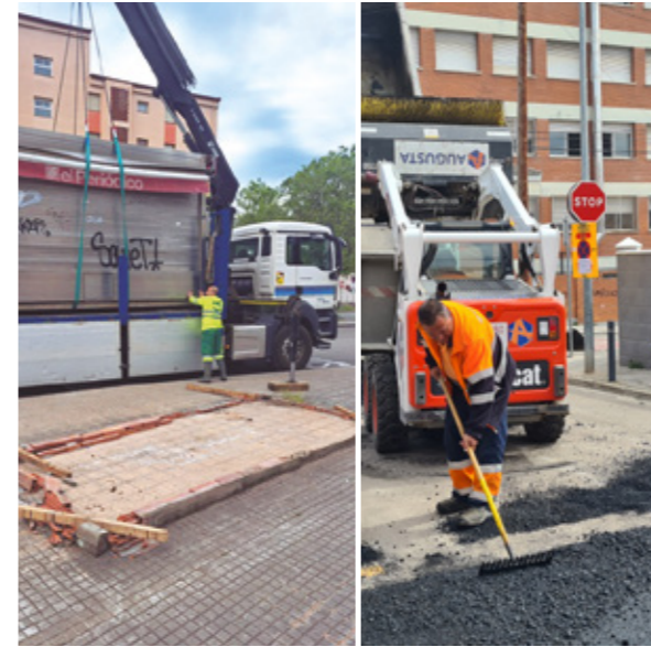
Retirada de quiosco y asfaltado en la calle del Arboç
