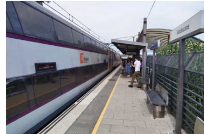
La renovació de l'estació tindrà una durada d'uns 15 mesos
