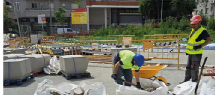
Los trabajos tienen una duración aproximada de cuatro meses
